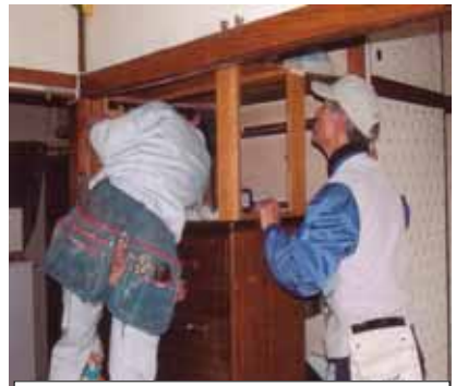
家具転倒防止器具の取付工事施工例
