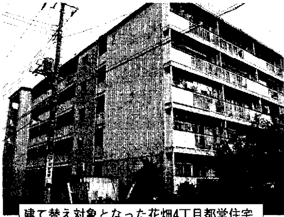
建て替え対象となった花畑4丁目都営住宅
